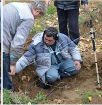
Вскрытие грунта, поведенное механизированным способом по намеченной посредством искателя КМС-КИ трассе и с учетом глубины, определенной искателем КМС-КИ, показало наличие в траншее двух кабелей и двух ремонтных вставок.
