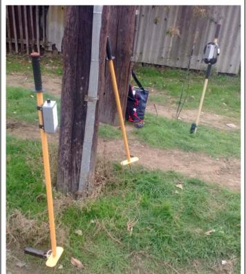
Кабельная линия на таксофон сведена со столба внутри жестяного короба на деревянной опоре столба. Уровень сигнала на входе «Антенна» вблизи свода по показаниям искателя КМС-КИ (речевое воспроизведение) составляет -98 дБ
