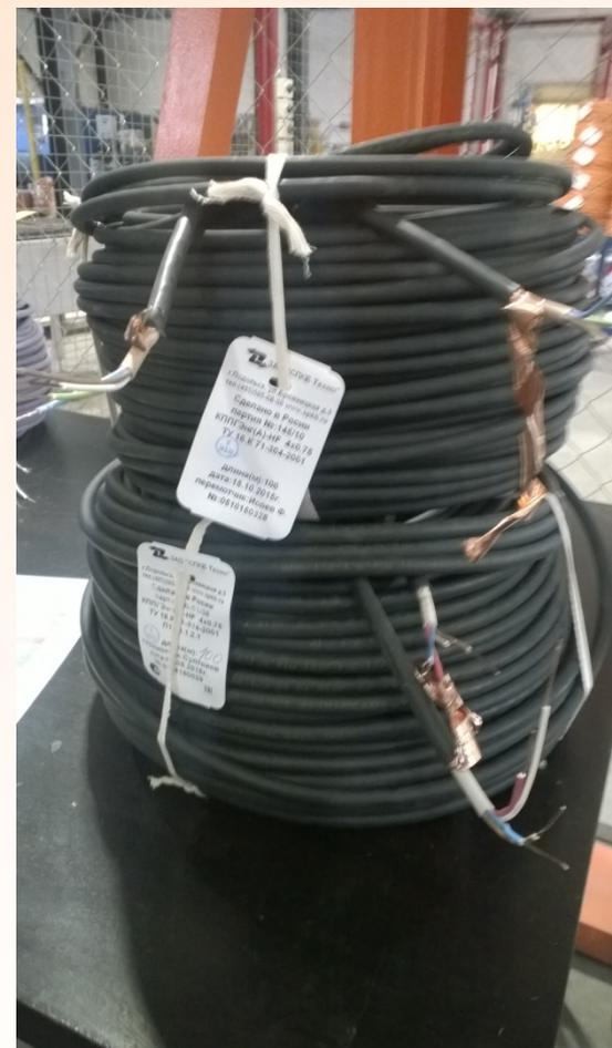
КППГЭнг(А)-HF 4\*0,75. Сеч.=0,75кв.мм.
